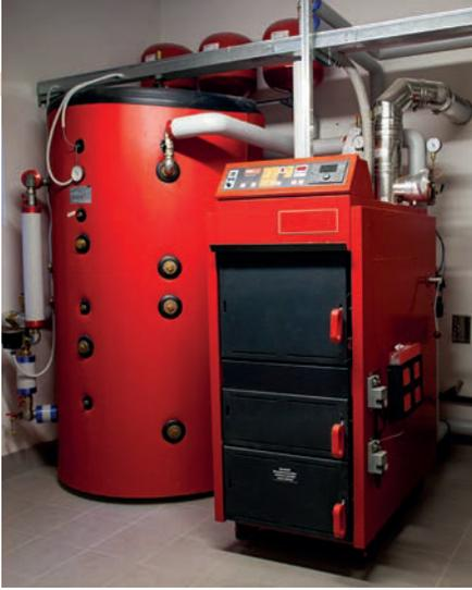
Foto 1 – Una caldaia a legna correttamente abbinata all'accumulo inerziale.
